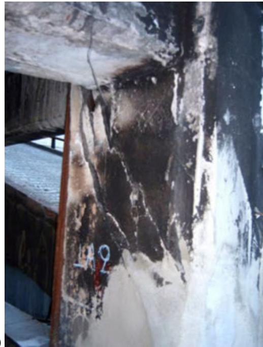
Εικ. 3 Θερμικό “λάκτισμα” στύλων α) Σ20, β) Σ22 στο τμήμα μεταξύ ισογείου και μεσοπατώματος
