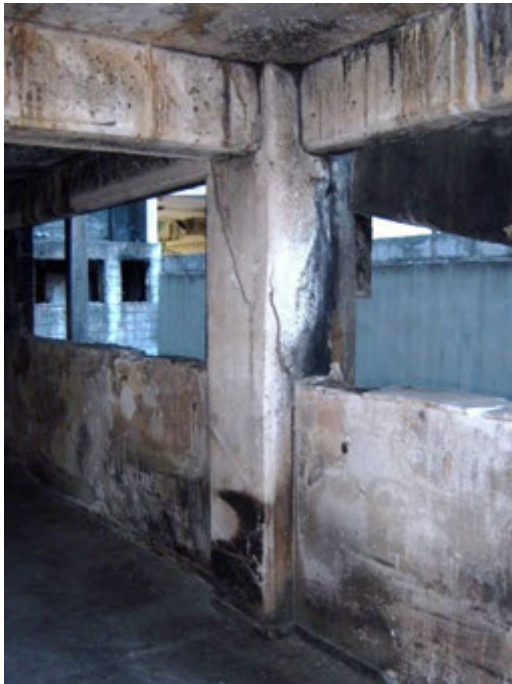
Εικ. 3 Θερμικό “λάκτισμα” στύλων α) Σ20, β) Σ22 στο τμήμα μεταξύ ισογείου και μεσοπατώματος
